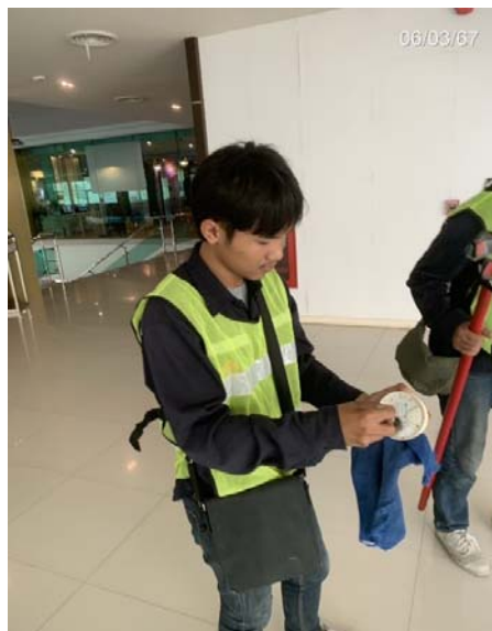
ภาพปฏิบัติงานการ Test Smoke Detector
