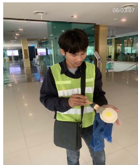
ภาพปฏิบัติงานการ Test Smoke Detector
