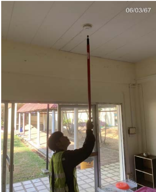
ภาพปฏิบัติงานการ Test Heat Detector
