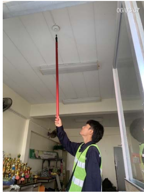
ภาพปฏิบัติงานการ Test Heat Detector
